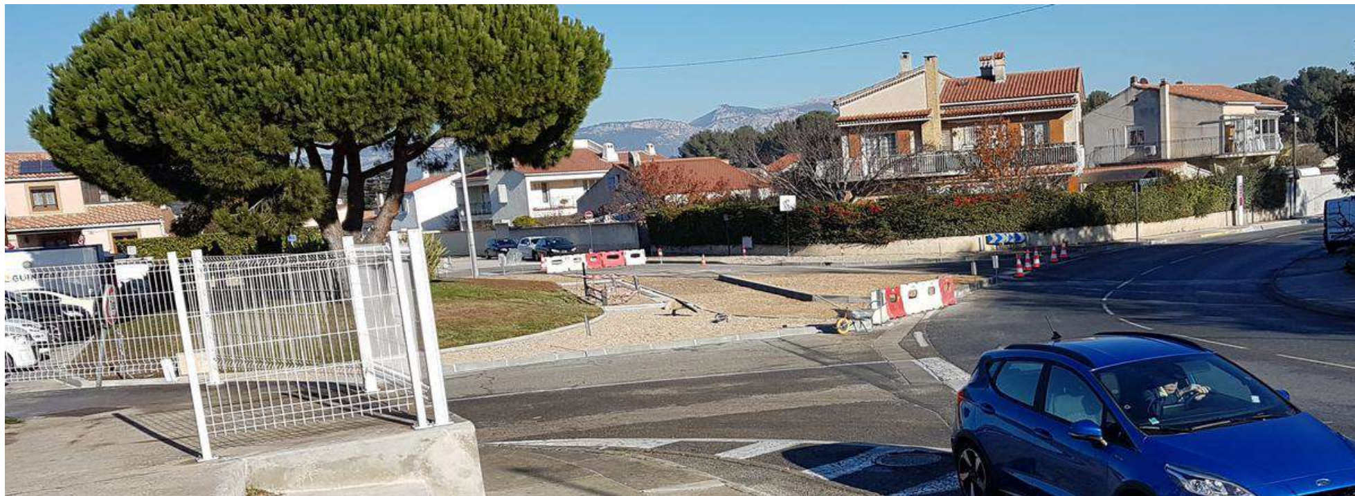
Sortie Ch. Du Verger - Route de Janas en cours de réalisation
