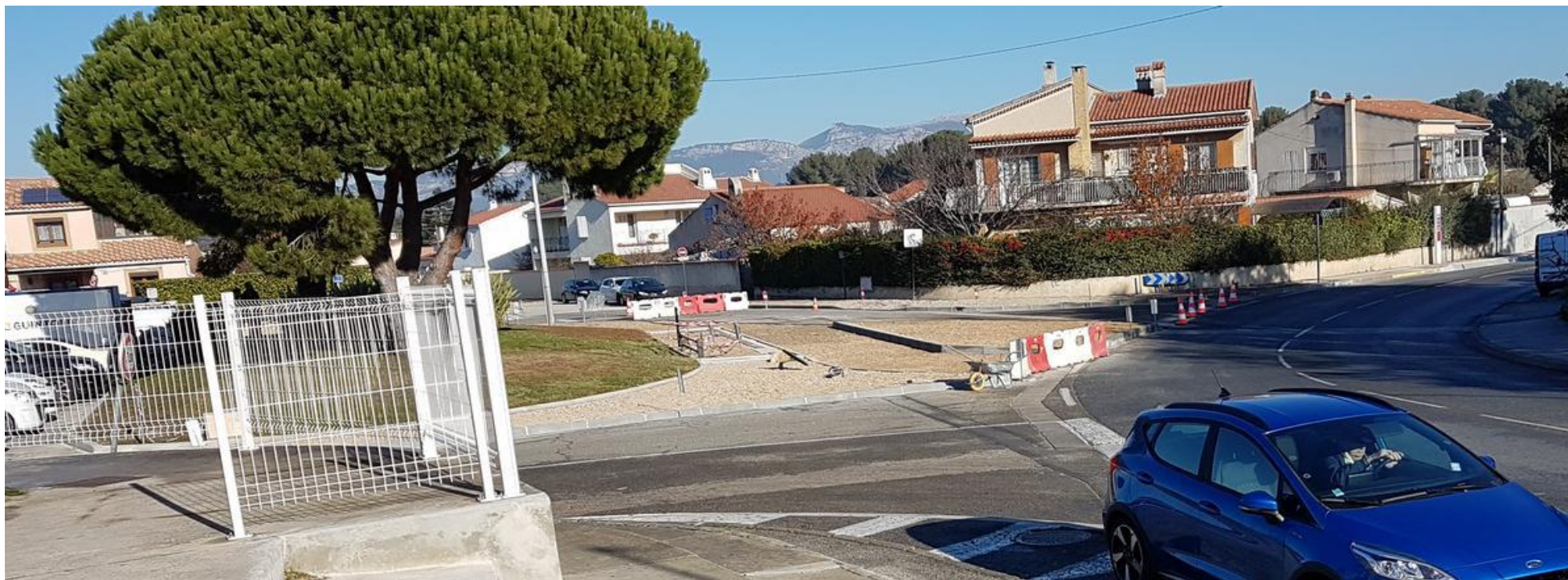
Sortie Ch. Du Verger - Route de Janas en cours de réalisation( 01.22)
